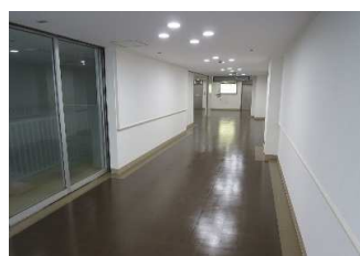
【1階 中央通路(改修済)】
