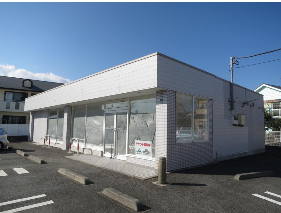
【外観写真】※外壁目地コーキング、一部塗装実施
