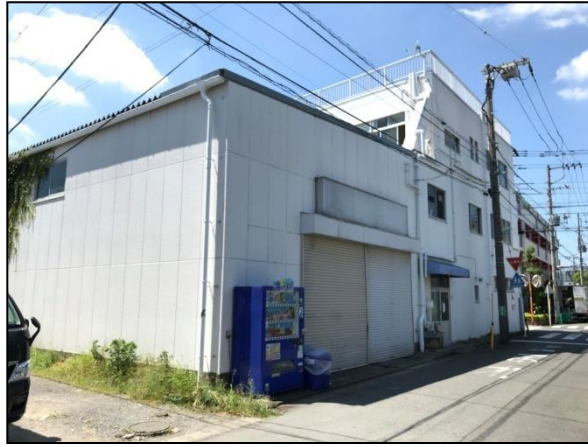
【建物北側 シャッター内車両進入可】
